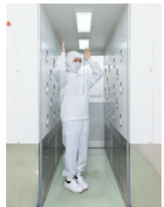
作業着に付着した異物をエアシャワーで取り除きます
