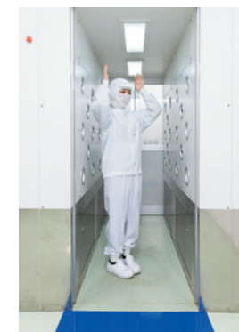
エアシャワー 作業着に付着した異物を強い風で取り除 きます
