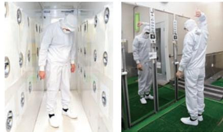
両脇の送風口から風が吹き出し、作業着に付着した異物を取り除きます
