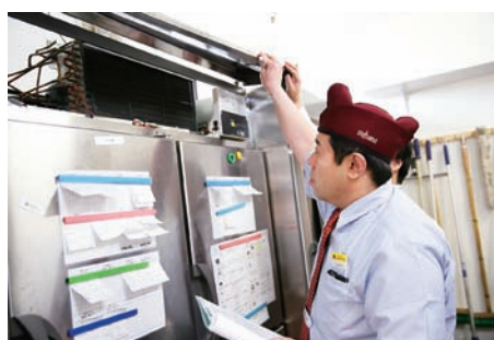
冷凍機の 定期点検の様子
